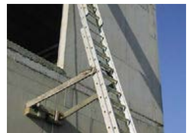
Figuur 1: Een bevestigingsmogelijkheid voor een ladder om te vermijden dat ze wegschuift
