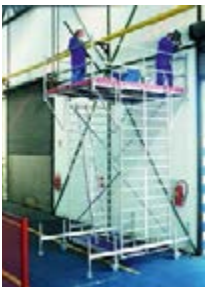
Figuur 21: Een voldoende brede basis voor de rolsteiger
