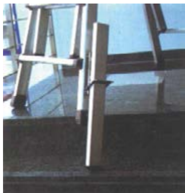
Figuur 10: Het gebruik van hulpstukken om een ladder op te stellen op een trap
