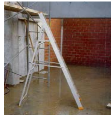
Figuur 12: Een ladder op een gladde betonvloer plaatsen kan zware ongevallen tot gevolg hebben
