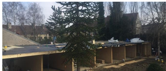
Don Bosco College - Duurzaam bouwen met houtskelet. DRTB is hier de aannemer.
